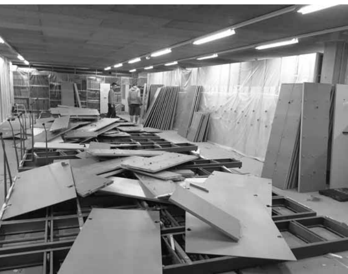
Remplacement d'un compactus dans les dépôts: un défi logistique.
